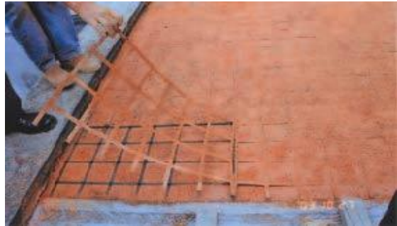
圖 6.4 拆除「空調導水管架構」上蓋
