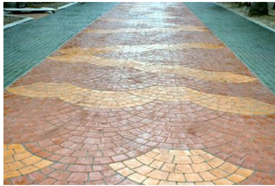
圖 6.6 噴灑養護劑後完工圖
