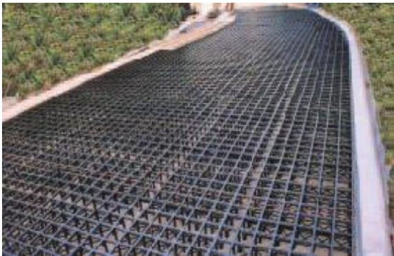
圖 6.1 鋪設空調導水管架構
