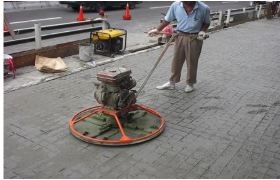
圖 6.3 施灑色粉硬化料並拍漿整平
